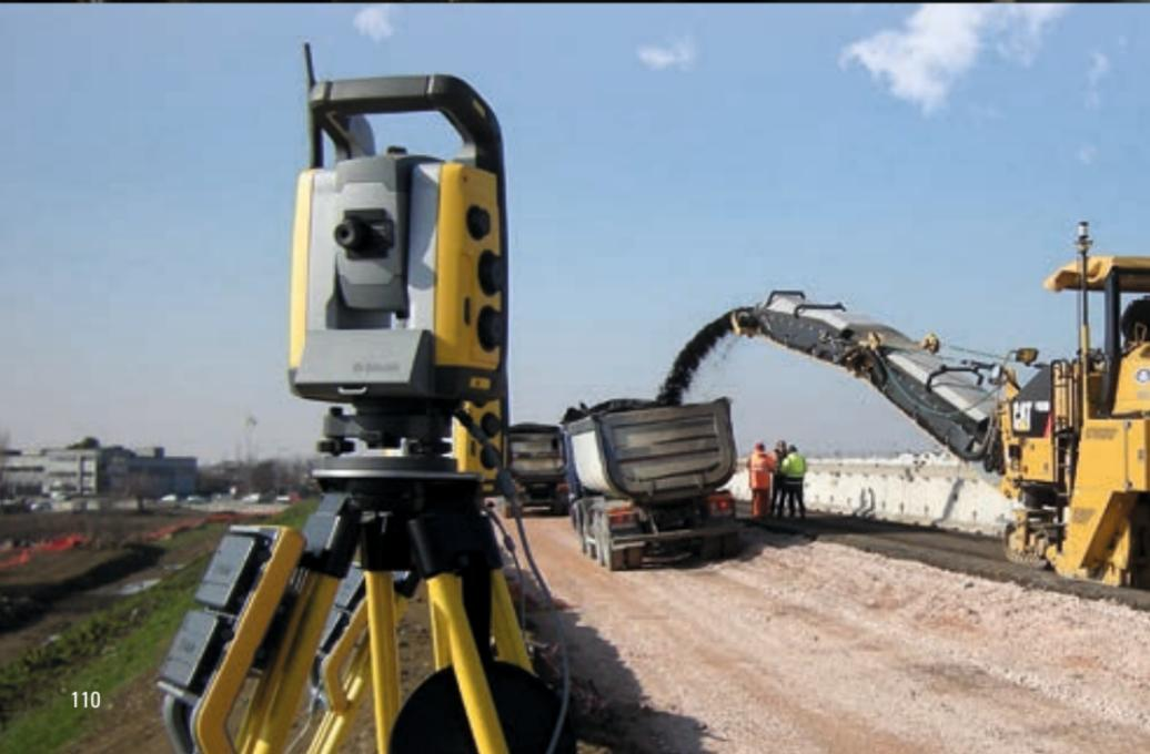
Maschinensteuerungssysteme nutzen vorhandene Planungsdaten, um die Baumaschinen bei der Herstellung der vorgegebenen Geländekontur zu führen und zu steuern. Hierdurch entfallen fast alle Vermessungsarbeiten auf der Baustelle sowie das zeitaufwendige Annähern an das Soll-Maß. Die Systeme sind heute so ausgereift und bedienerfreundlich, dass sie auch bei kleinen und mittleren Bauprojekten erstaunliche Produktivitätssteigerungen erzielen.
